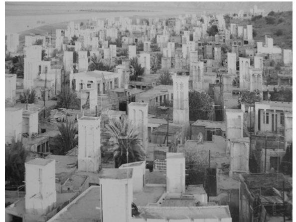
تصویر ۱. بادگیرهای روستای لافت در جزیره قشم نتیجه خرد جمعی مردم لافت است.
