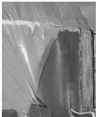
ت ۴. استفاده از اندود کاهگل جهت افزایش مقاومت حرارتی دیواره آلاچیق
