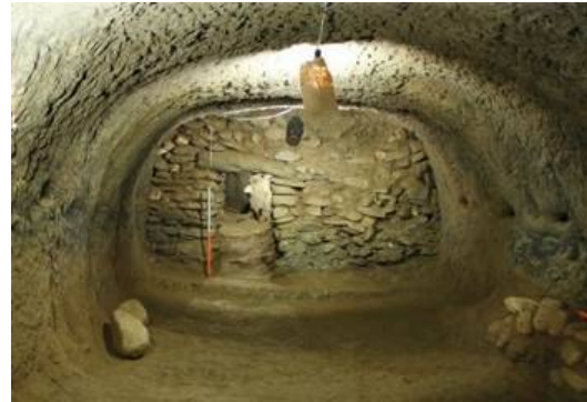
ت 11. نمایی از فضای زیرزمینی ارزانفود، اثرات کنده‌کاری و پوشش قوسی سقف (محمد شعبانی، 1390).
