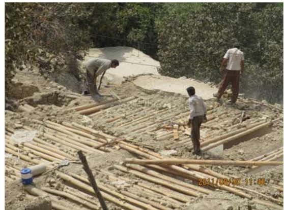
ت ۵. تفکیک مصالح قابل استفاده از مصالح آوار. (منبع: آرشو بنیاد مسکن)
