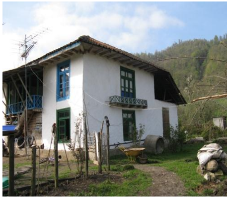
ت ۳. فضاها و عناصر معماری خانه، در تلفیق با فضای عمومی معبر. مأخذ: آرشیو تصاویر نگارندگان.
