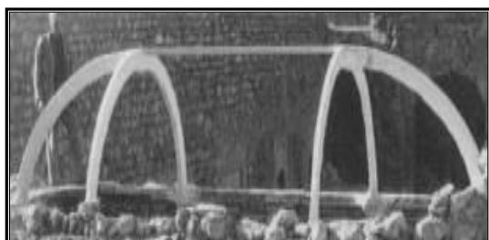
ت ۹. استفاده از قالب گچی برای ساخت تاق لی لی پوش با استفاده از مصالح سنگی (منبع: آرشو شخصی دکتر فخار تهرانی).
