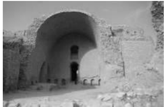
ت ۸. اجرای تاق آهنگ با استفاده از دیوار پشتواره. آتشکده فیروز آباد، استان فارس (منبع: نگارندگان).
