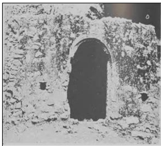
ت ۶. در ورودی آسیاب آبی تنگه شیخ‌مکان با طاق هلالی (ایزدپناه، ۱۳۵۰: ۵۲۰).
