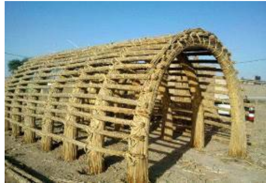
ت 20. بافت سازه اصلی مضیف. (تهیه تصویر: نگارنده).
