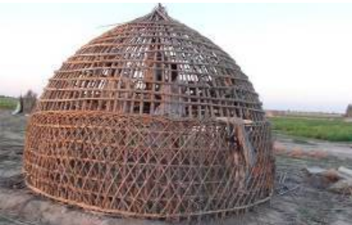
ت 17. مراحل ساخت سقف و دیوار کپر. (برگرفته از سایت: http://www.halil.ir ).
