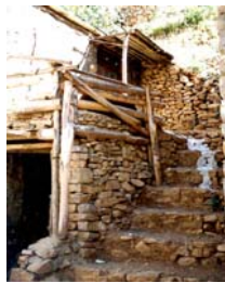
تصویر شماره دو: خانه‌ها و مصالح ساختمانی غالب روستا. ماخذ: منبع ۳۰
