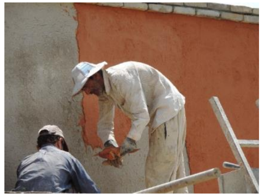
ت ۷. استفاده از سیمگل بر روی اندود کاهگل. مأخذ: نگارنده.
