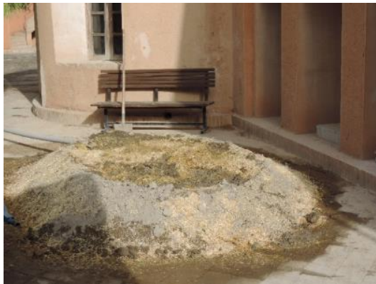
ت ۱. مخلوط کردن خاک و الیاف کاه برای تهیه کاهگل. مأخذ: نگارنده.
