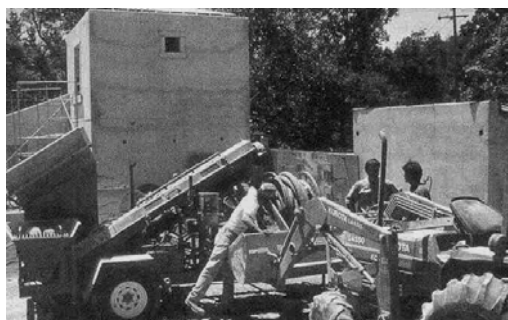
الف: یک تراکتور برای بار کردن، یک دستگاه مخلوط کن، کوبه دستی، و یک کمپرسور بزرگ که وسایل مورد نیاز در سازه خاک کوبیده را تشکیل می‌دهند.
