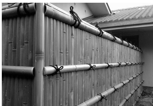
تصاویر ۷- دیوارهای ساخته شده با ساقه بامبو
