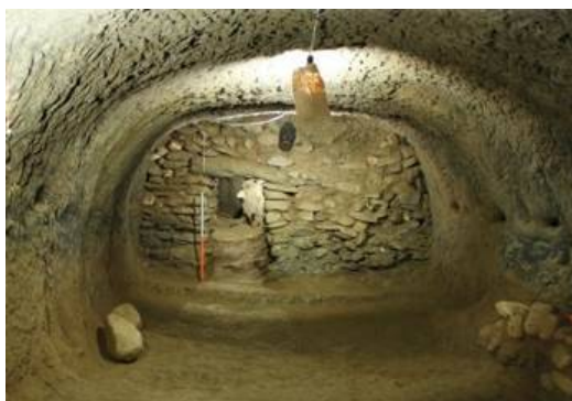
ت 11. نمایی از فضای زیرزمینی ارزانفود، اثرات کنده‌کاری و پوشش قوسی سقف (محمد شعبانی، 1390).
