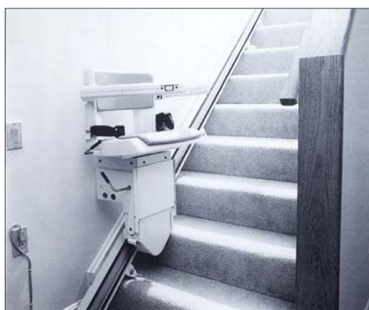
تصویر ۱۲- نصب بالابر بر روی پله
