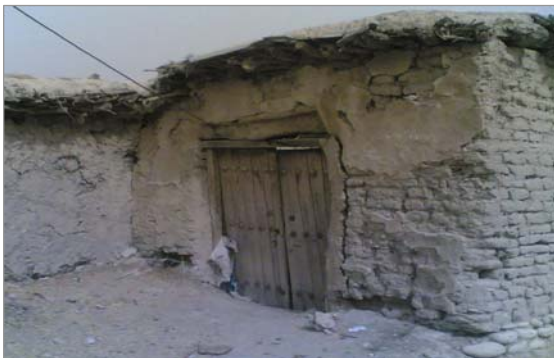
تصاویر شماره ۱، ۲ و ۳: نمونه‌ای از ساخت خانه‌های مسکونی قدیمی با مصالح موجود در محیط، در روستاهای گر، پل و جنجان فهلیان در شهرستان ممسنی (بهار ۱۳۸۷).
