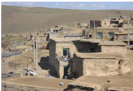
تصویر شماره ۷: دیوار کاه گل و دیوار سنگی از جنس سنگ گچ محلی (روستای کانی کبود)
