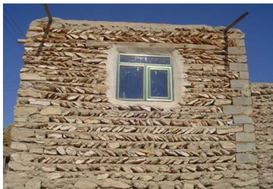
تصویر شماره ۷: دیوار کاه گل و دیوار سنگی از جنس سنگ گچ محلی (روستای کانی کبود)
