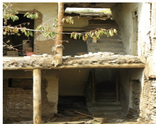
"ت ۱۱ الی ۱۴" جزئیات اتصال ستون به سقف در مدرسه قدیمی سنگان.
