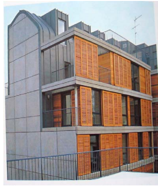
تصویر ۲: نمونه ای از بناهایی که با تدابیر مختلف میزان تابش نورخورشید به داخل و یا تبادل حرارتی داخل و خارج آنها کنترل شده، و در نتیجه در مصرف وسایل مربوط به تهویه خانه به نوعی صرفه جویی می گردد.
