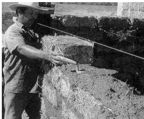
ب: اجرای دیوار رس-سبک
