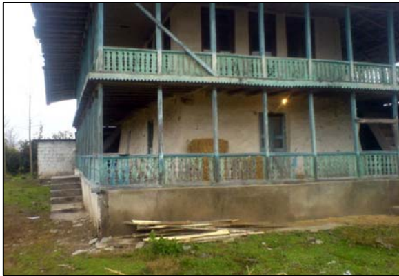
تصویر شماره ۱: یک نمونه از الگوی ساخت و ساز و نوع معماری مسکن در دوره قبل از اجرای طرح هادی (دافچاه)
