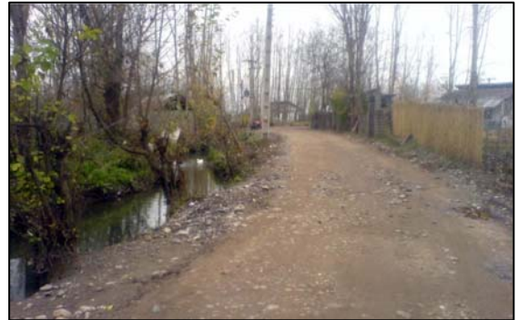
تصویر شماره ۶: نمونه‌ای از عدم وجود سیستم مناسب برای هدایت آبهای جاری و آبگرفتگی جاده‌ها
