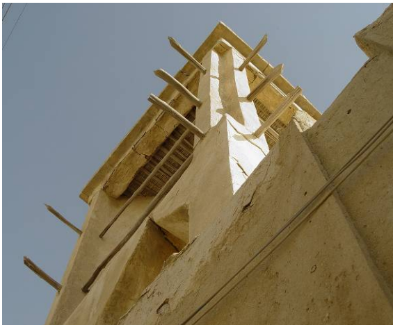
تصاویر شماره ۹: استفاده قابل توجه از مصالح مقاوم کننده سازه در برابر نیروی زلزله مانند چوب در سازه‌های بادگیر بافت روستایی بندر لافت. مأخذ: نگارندگان، تاریخ برداشت تصویر: ۱۳۸۰
