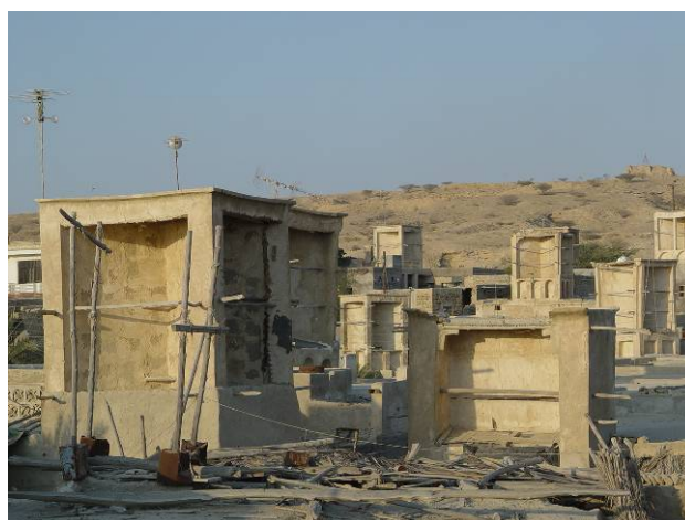
تصاویر شماره ۹: استفاده قابل توجه از مصالح مقاوم کننده سازه در برابر نیروی زلزله مانند چوب در سازه‌های بادگیر بافت روستایی بندر لافت. مأخذ: نگارندگان، تاریخ برداشت تصویر: ۱۳۸۰
