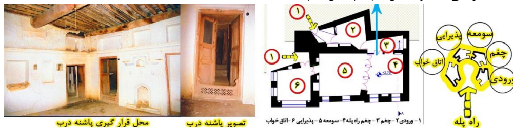
شکل ۲۳. قرارگیری پاشنه درب ابنیه مسکونی سنتی ماسوله
