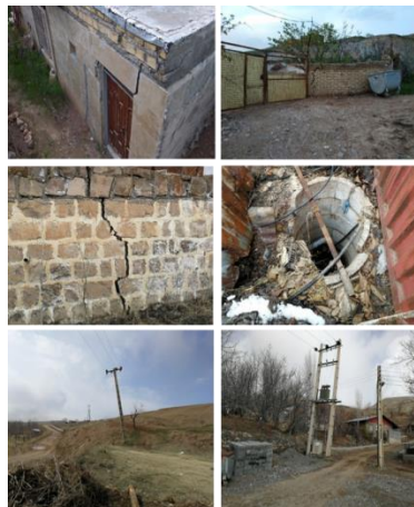
شکل ۱۵. شکاف‌های ایجادشده در دیوار واحدهای مسکونی در بخش‌های شرقی و غربی روستای علی‌آباد و خارج شدن دهانه چاه از شکل دایره به بیضی در بخش غربی روستا
