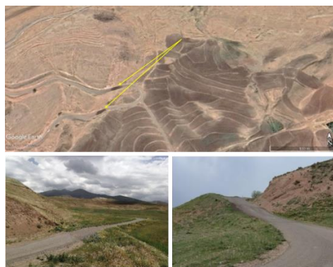
شکل ۱۴. آثار گسیختگی حاشیه غربی زمین‌لغزش به جاده ارتباطی روستای اویرک
