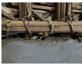
شکل ۳. نحوه استقرار شاک در داخل دیوار سیمان
