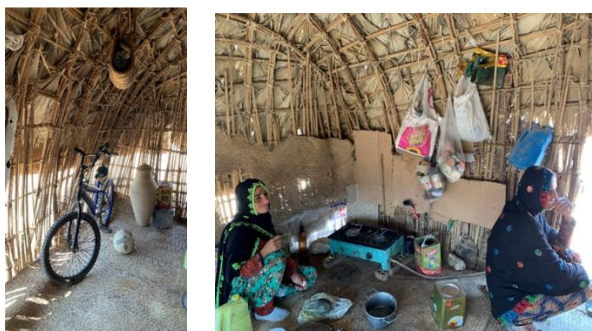
شکل ۵. فضای داخلی یک کپر خدمات، یک سمت در نقش انبار خانواده و سمت دیگر آشپزخانه
