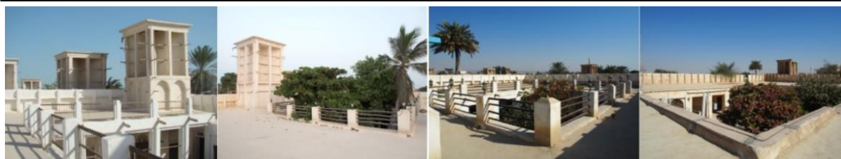
شکل ۷. بام در خانه‌های بندر کنگ
