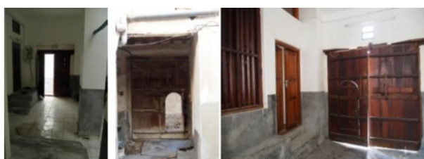
شکل ۸. ورودی در خانه‌های بندر کنگ
