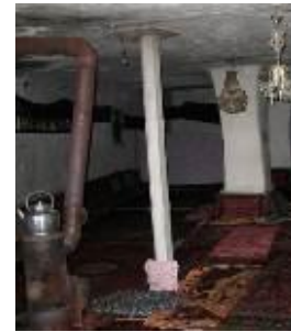
شکل ۲۳. افزوده شدن ستون دوم به مسجد جامع عنصرود در طی تعمیرات دوران کرونا، تصویر راست: ۱۴۰۲ و تصویر چپ: ۱۳۹۶
