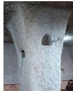
شکل ۲۱. الف: جاشمعی‌های تعبیه شده در بدنه ستون‌ها
