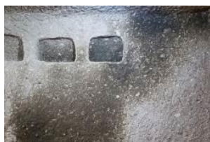
شکل ۲۹. بیرون آمدن طاقچه بالاهاى متعدد در طی تعمیرات دوران کرونا، تصویر راست: رازانی، ۱۳۹۶ و تصویر چپ: ۱۴۰۲
