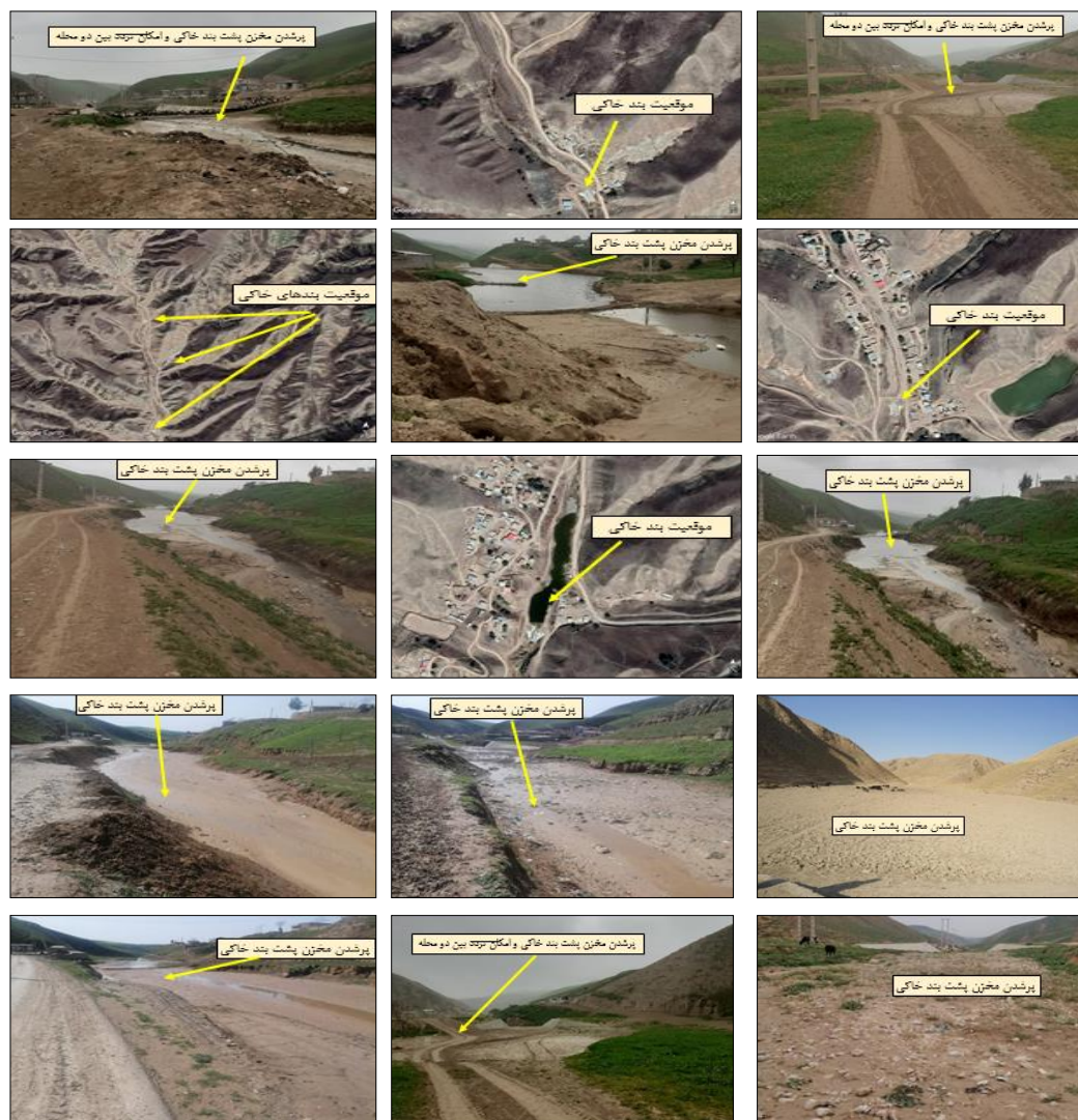
ت ۵. نمایی از موقعیت و عملکرد سازه‌های مکانیکی اجرا شده در مناطق بحرانی روستا و تأثیر آن در کنترل گالی‌ها
