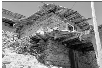
ت ۸. تفاوت در جنس مصالح دیوار در طبقه همکف و طبقات فوقانی
