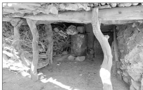
ت ۱۲. استفاده از ستون‌های چوبی به‌منظور حمل بار
