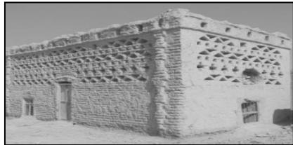
ت. ۱۶. استفاده از مصالح با ظرفیت حرارتی مناسب، تعییه پنجره‌ها در پایین‌ترین ارتفاع جداره، استفاده از نقوش هندسی و استفاده از کلاهک تهویه هوا در بام راهکارهای اقلیمی جهت آسایش حرارتی در مسکن این ناحیه می‌باشد کاپار یا کاپر
