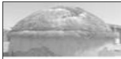
ت ۱۳. جداره استوانه‌ای توب از چوب با خشت و سقف گنبدی آن از شاخه‌های نخل ساخته می‌شود
