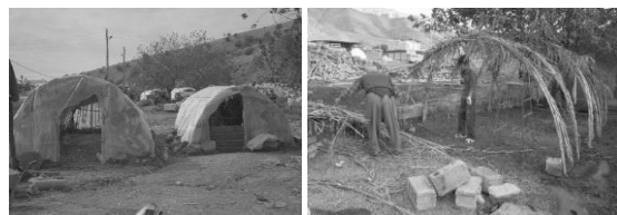
ت ۱. نمونه کپرهایی در حال ساخت توسط روستاییان
