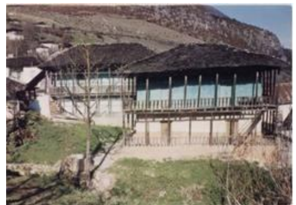
"ت 8" پوشش سقف با مصالح جدید (ایرانیت) و مصالح سنتی (لت).
