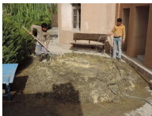
ت ۲. آخوره بستن خاک و الیاف کاه برای اختلاط با آب. مأخذ: نگارنده.
