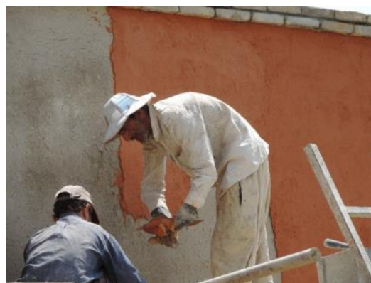
ت ۷. استفاده از سیمگل بر روی اندود کاهگل. مأخذ: نگارنده.
