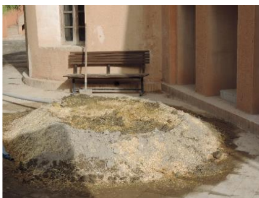
ت ۱. مخلوط کردن خاک و الیاف کاه برای تهیه کاهگل. مأخذ: نگارنده.
