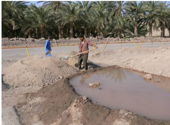
ت ۱. مخلوط کردن مصالح و آخوره کردن.
