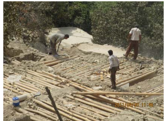
ت ۵. تفکیک مصالح قابل استفاده از مصالح آوار. (منبع: آرشیو بنیاد مسکن)
