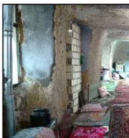
شکل ۲۷. اجرای آجر و ملاط سیمان برای جداسازی دو فضا
