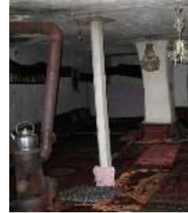
شکل ۲۳. افزوده شدن ستون دوم به مسجد جامع عنصرود در طی تعمیرات دوران کرونا، تصویر راست: ۱۴۰۲ و تصویر چپ: ۱۳۹۶
