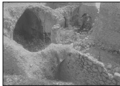
ت ۵. سقف تخریب شده عمارت دشتی (۱۳۹۸).
