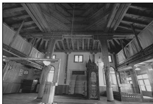
ت ۹. ساخت سقف چوبی مسجد Konursu Ulu ترکیه به روش Kurlangıç Örtü.
