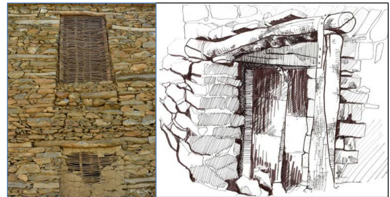
ت 3. اتصال نعل درگاه چوبی به ستون چوبی، دیوارهای مشبک (در زبان محلی تیمان)، استفاده از شبکه مدولار در بازشوها. منبع: نگارنده اول.
