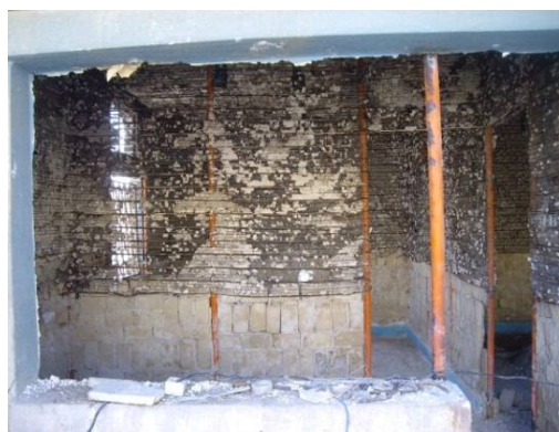
ت 4. اسکلت ساختمان‌های بازسازی شده. مأخذ: نگارندگان سال 90.
