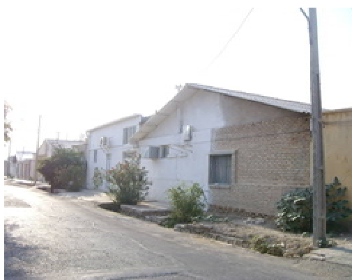
ت 6. نمای خارجی خانه‌های بازسازی شده. دو پلاک مجاور یکدیگر. مأخذ: نگارندگان، سال 90.
