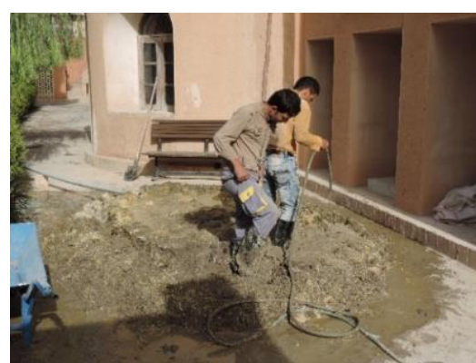
ت ۳. ورز دادن کاهگل با لگد کردن آن توسط نیروی انسانی. مأخذ: نگارنده.
