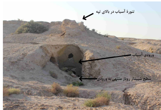
ت 11. چگونگی قرارگیری فضاهای دستکند آسیاب گور آباد در تپه رسی بستر آسیاب. مأخذ: نگارندگان.
